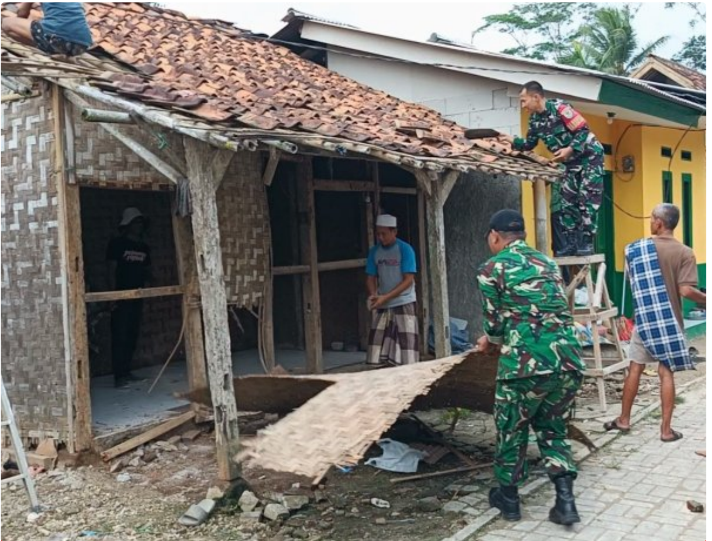
Pembongkaran Rumah Bapak Narmin
