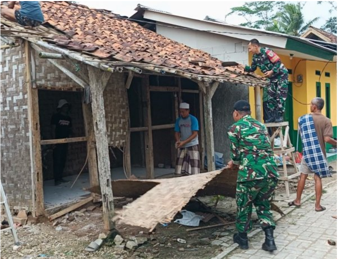
Pembongkaran Rumah Bapak Narmin
